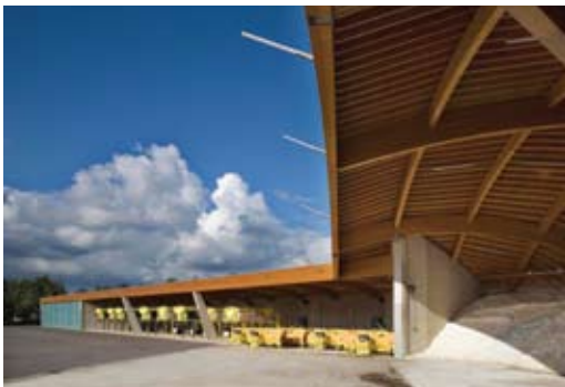
Opslagloods wegeenzout Breda.
