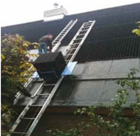
Plaatsen van groendakrasters op afschuifprofielen
