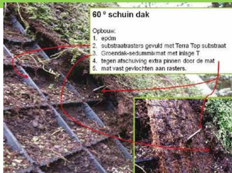
Bij 60° moet het verantwoord vastliggen: spouwankers en type T sedummat.
